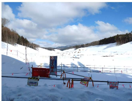
積雪状況（防災調整池）
